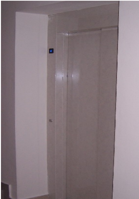
pohľad na šachtové dvere výt'ahu
