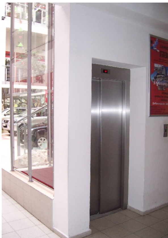
pohľad na šachtové dvere a časť šachty
