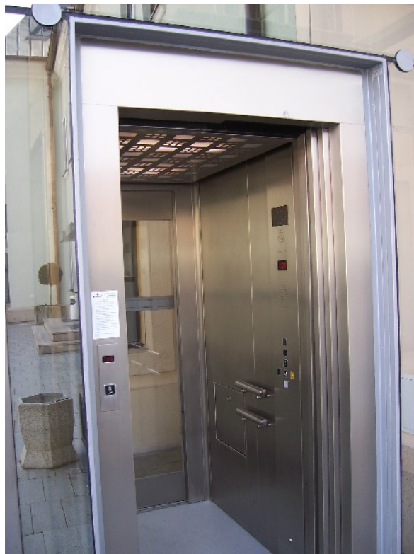
pohľad do kabíny výt'ahu z nádvorja
