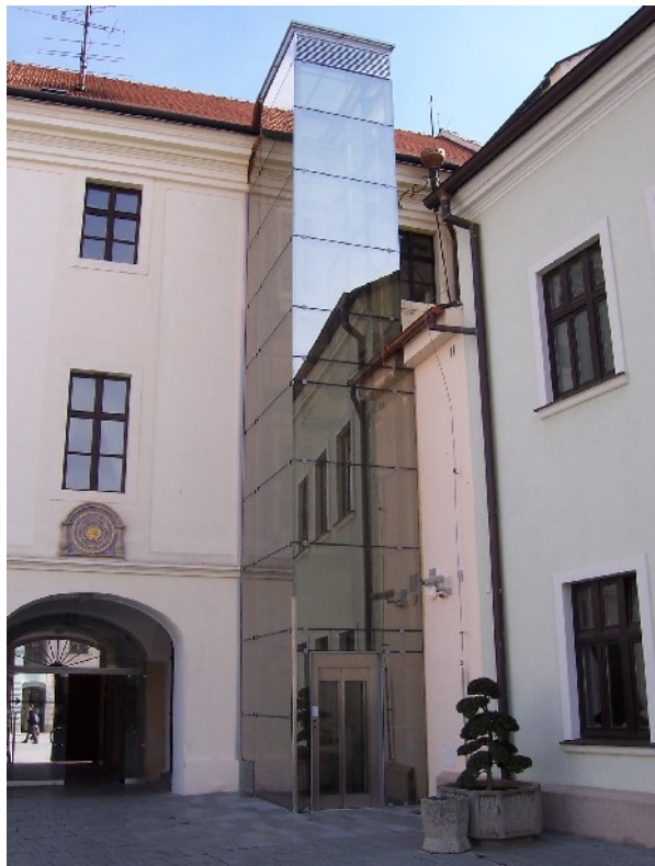
pohľad z nádvorja na šachtu výt'ahu
