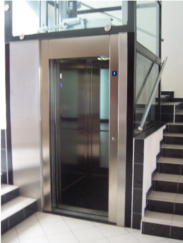
pohľad na šachtu výťahu
