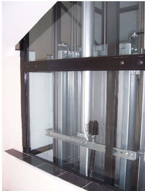
pohľad na kotviacu stenu – hydr. piest
