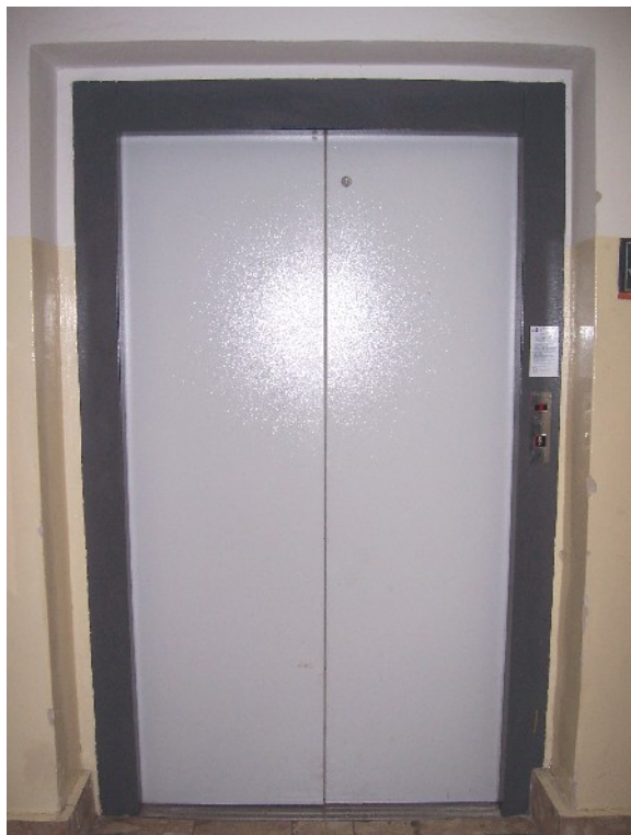
pohl'ad na šachtové centrálne dvere
