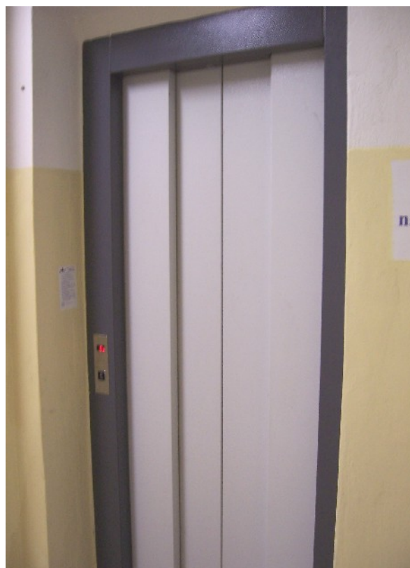
pohl'ad na šachtové centrálne dvere
