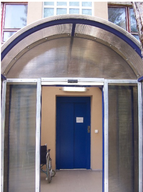
pohľad na vstup do výťahu
