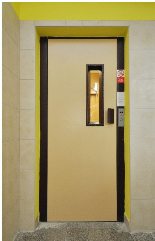
pohľad na šacht. dvere v murovanej šachte
