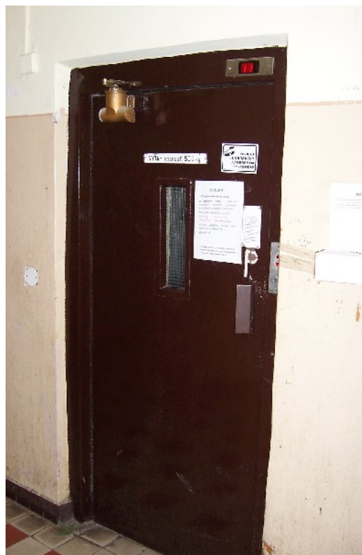
pohľad na murovanú šachtu a šacht. dvere
