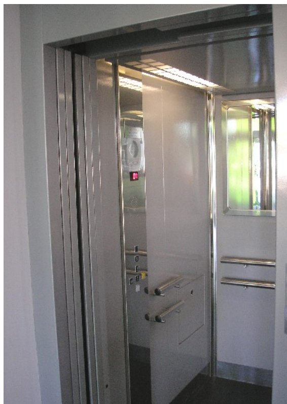
pohľad do kabíny výt'ahu
