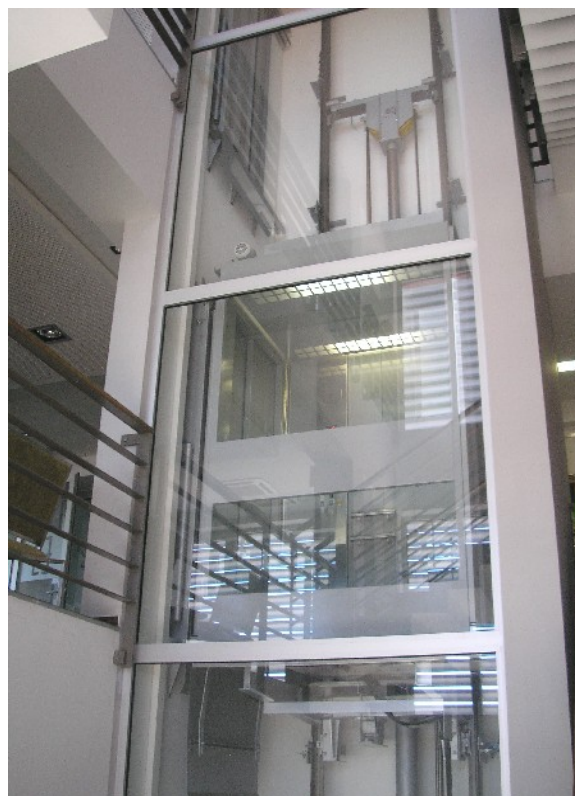
pohľad na šachtu a kabínu výt'ahu / sklenenú stenu/
